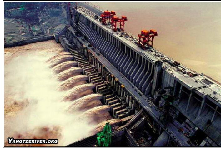
Figura 9.- imagen de la presa de las tres gargantas (China).
