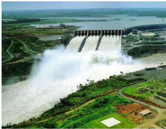
Figura 4.- Imagen de la presa de Itaipú (Brasil), segunda mayor del mundo.
