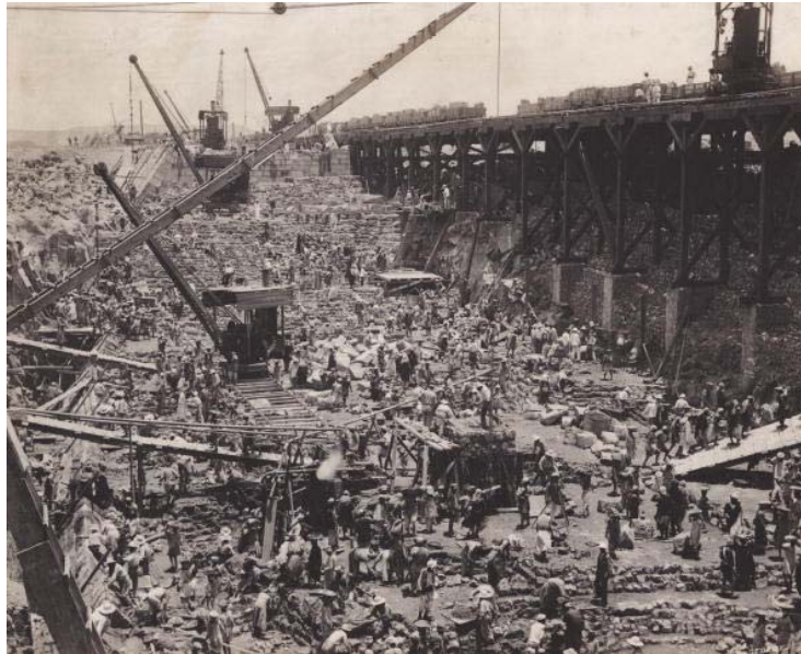
Figura 7.- im(agen del proceso de construcción de la presa de Aswan (Egipto).
